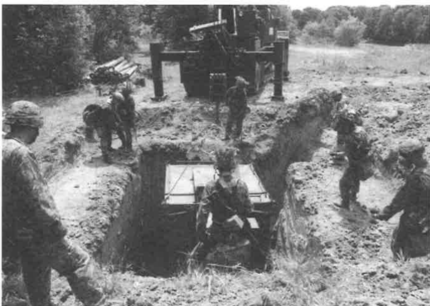
通信所の簡易掩蓋の様子
