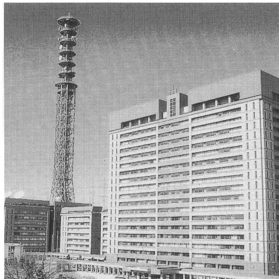
市ヶ谷A棟及び通信鉄塔
