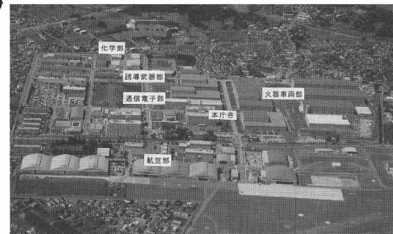
関東補給処本処の建設状況
